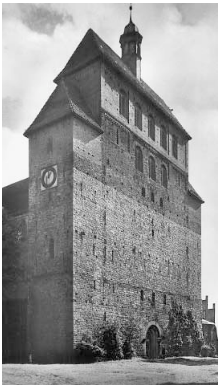
Dom zu Havelberg, Westbau
